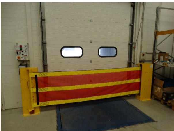
Figure 20 e 21. Nastro avvolgibile posto a protezione di una baia di carico contro il rischio di caduta
