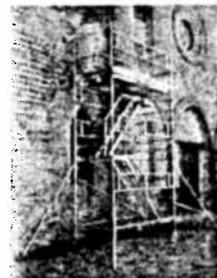
Non superare un'altezza "ragionevole" (all'esterno la norma UNI EN 1004 fissa ad 8 metri il massimo) ed ancorare la struttura alla costruzione almeno ogni 2 piani di ponte (se non altrimenti specificato nel manuale).
